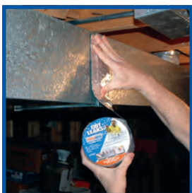
Brtvljenje unutarnjih instalacija
